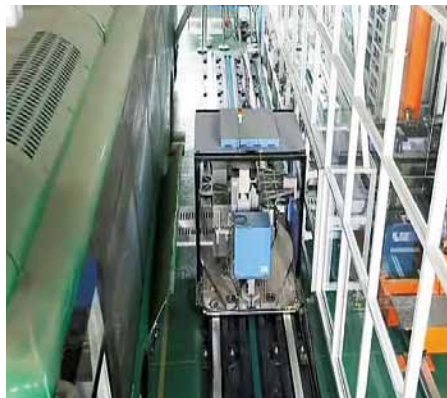
バッテリー交換用ロボット
